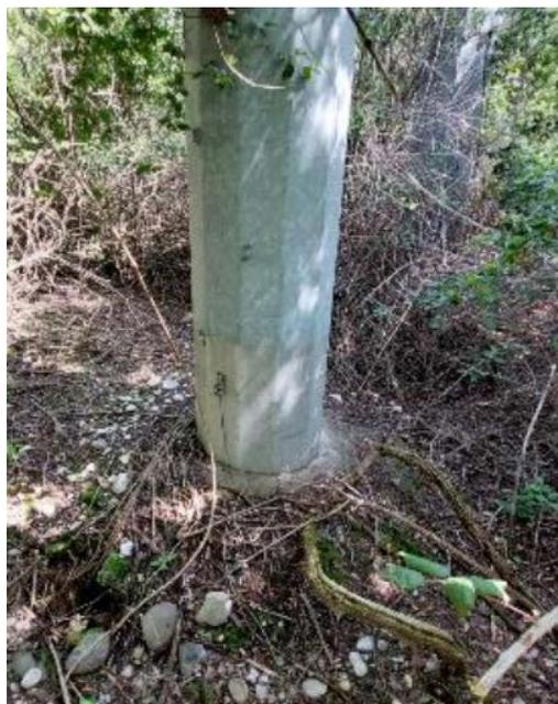
3. Pylône électrique au PR85,46 - les pieds du pylône ne semblent pas protégés contre les érosions externes – en cas d'érosion atteignant ses pieds, le pylône chuterait et entrainerait avec lui les câbles électriques sur l'autoroute (la ligne traverse l'A51 à proximité) - visite du 26 mai 2023
