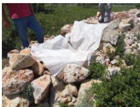
Figure 74 : Photographie de la pose du géotextile sur l'abri (P.Demonfaucon ECOMED)
