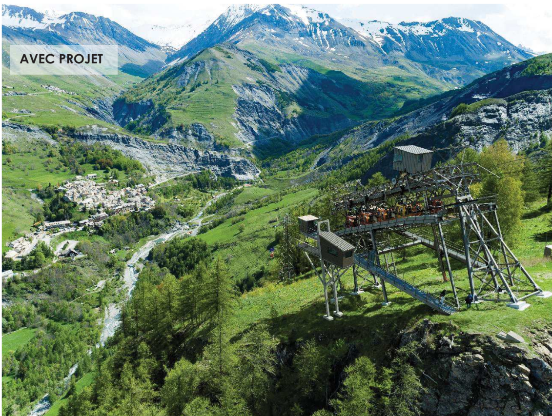
Insertion paysagère de la plateforme de départ de la tyrolienne sur le pylône 1 AVEC PROJET . Source : Plasticien Clément FACY
