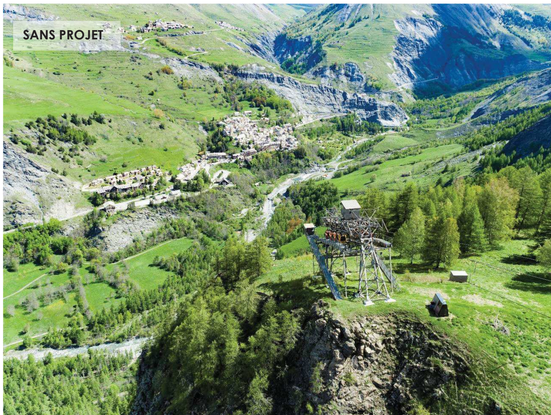
Photographie de l'état sans projet du pylône 1 sur lequel s'insère la plateforme de départ de la tyrolienne. Source : Clément FACY
