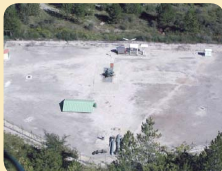
Isolement d'une tête de puits par rapport à la végétation environnante sur le site de Géométhane
