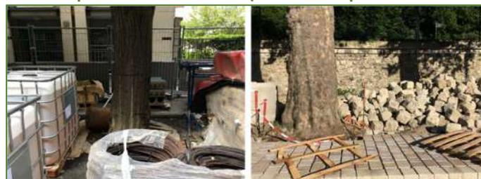
Exemples à ne pas suivre (arbres non protégés et impactés par les travaux)
