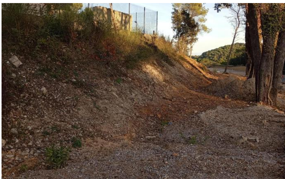
Vue depuis l'ouest du talus nord
