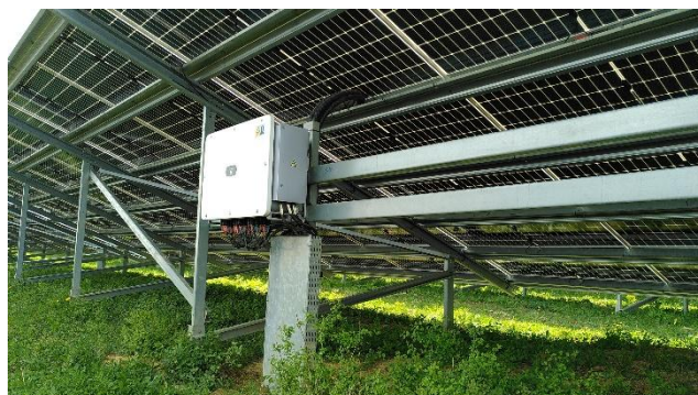
Exemple d'onduleur accroché derrière les tables de modules
