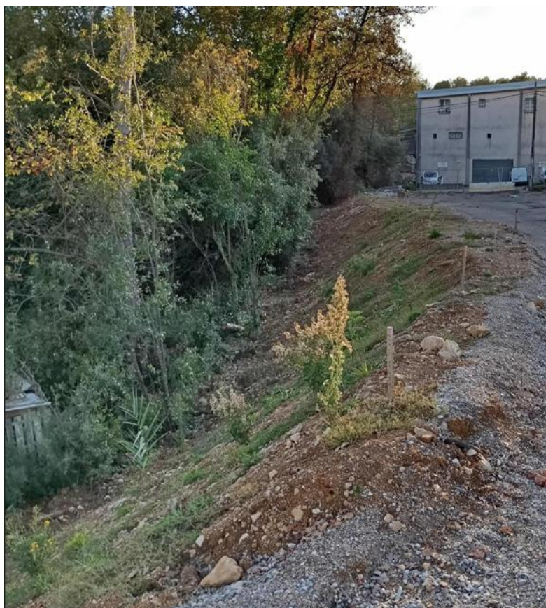
Vue depuis le nord du talus sud
