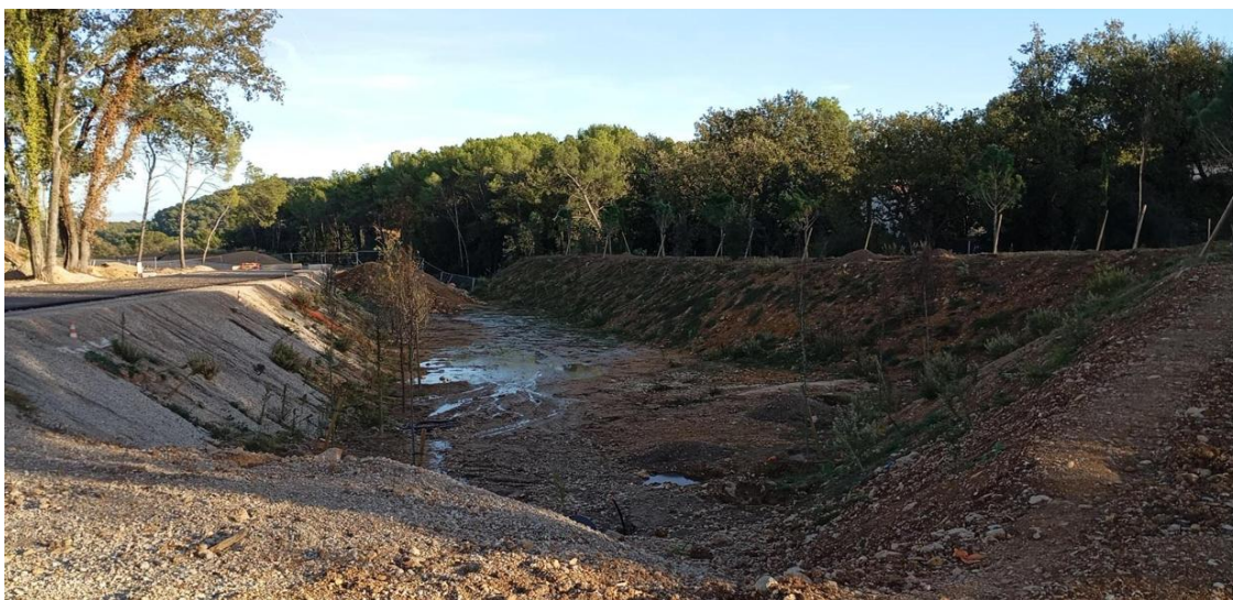
Vue depuis l'ouest du bassin
