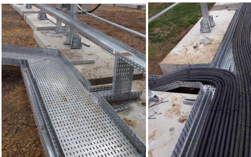
Exemple de chemin de câble aérien si impossibilité de terrassement de tranchées
