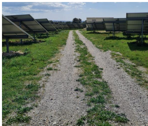
Exemple de chemin d'exploitation drainant
