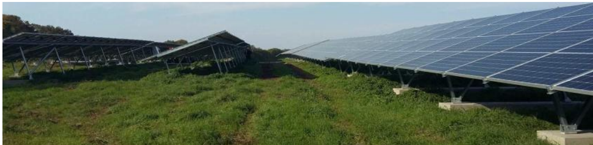
Structures utilisant des fondations bétons ou longrines
