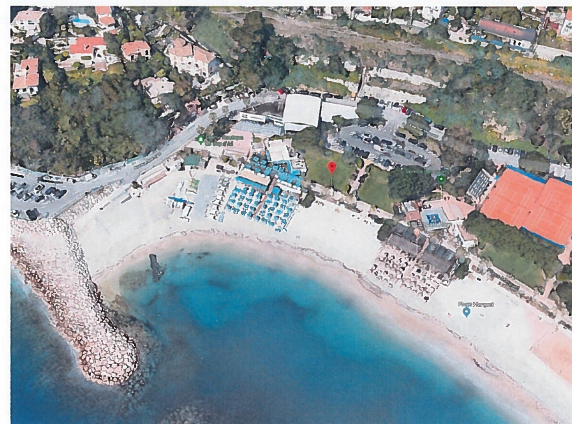
Vue Aérienne Est - 6
