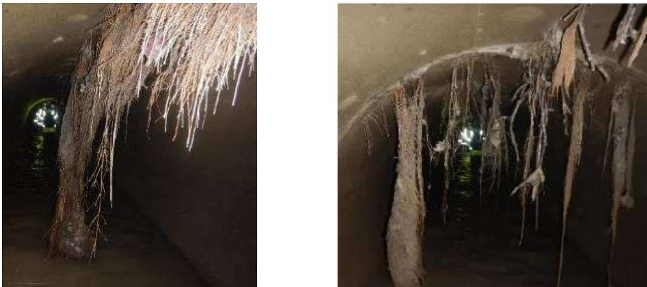
**Figure 2 : Invasion racinaire au sein de la conduite DN2000**
